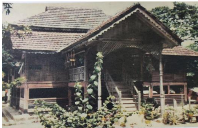
Fig. 1: Rumah Penghulu Haji Abbas or Rumah Pak Ali in Kampung Kerdas, Gombak
